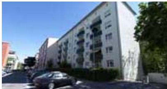
München, Karwendelstraße, Tiefgarage
