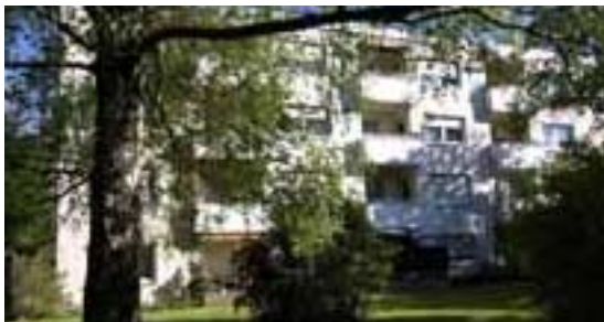
Germering, Schillerstraße, Gartenseite
