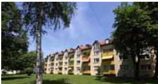
München, Cimbernstraße, Dachgeschossausbau
